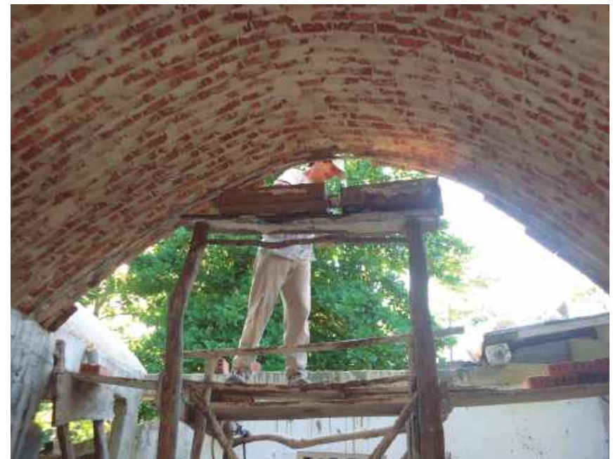
Cubierta abovedada con ladrillos de producción local
