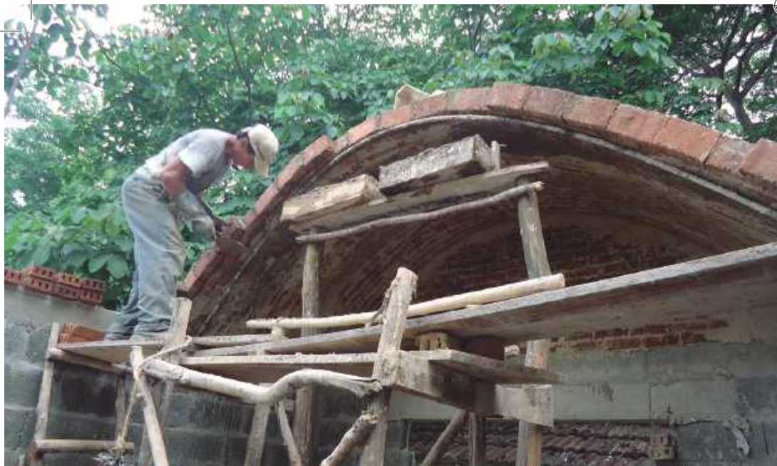
Titi fabricando una bóveda
